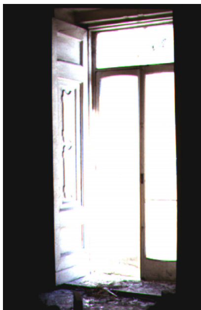
U.E. 18.4, Palazzo Lucarelli-Pacifico, via Seggio n. 92, scuro di un balcone del piano nobile, lungo la strada. Al pari dei pezzi d'opera collocati intorno al cortile, quelli presso la strada, pur presentando una più ricca scorniciatura del pannello centrale, sono realizzati a listoni e traverse emergenti su entrambi i lati.
