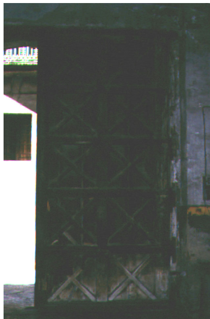
U.E. 24.2, Palazzo Gaudioso, via C. Golia n. 45, portone di castagno con stanti e traverse, tavolame esterno e croci di S. Andrea. Si tratta, forse, di un pezzo d'opera riutilizzato nel primo Novecento.
