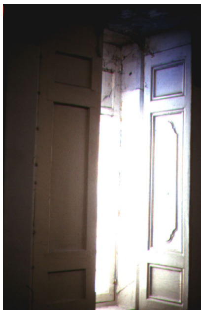
U.E. 18.4, Palazzo Lucarelli-Pacifico, via Seggio n. 92, scuro settecentesco di un balcone del piano nobile, sul fianco est del cortile. I cardini sono ad anello. Manca la ferramenteria.
