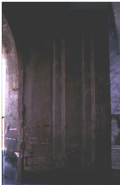
U.E. 24.2, Palazzo Gaudioso, via C. Golia n. 45, portone di castagno con stanti e traverse, tavolame esterno e croci di S. Andrea. Si tratta, forse, di un pezzo d'opera riutilizzato nel primo Novecento.
