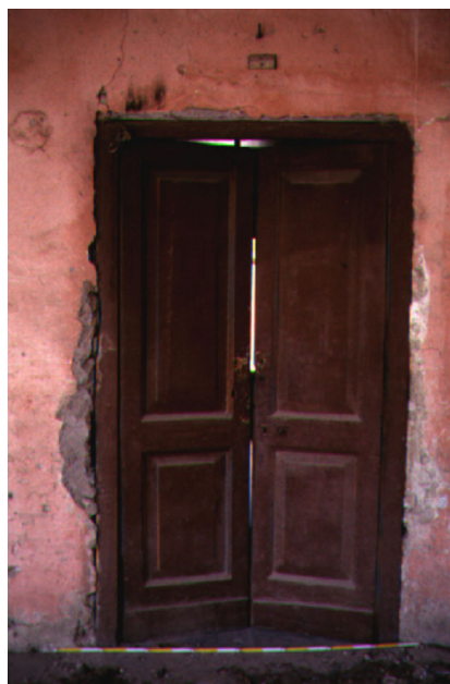
U.E. 42.1, Palazzo Caianiello, via S. Maria della Neve n. 34, porta di caposcala Nella profilatura principale, settecentesca, è inserito un pannello mistilineo, forse di analoga datazione, ma senza dubbio proveniente da altro pezzo d'opera, come dimostra l'incoerenza della sua sagomatura con quella del telaio.
