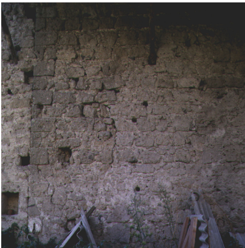
U.E. 32.10, vico S. Martella n.15. Superstite testata settentrionale di un edificio tardo-medievale. La muratura a cantieri di pezzame di tufo spaccato e di raccolta, ha nel cantonale blocchi squadrati.
