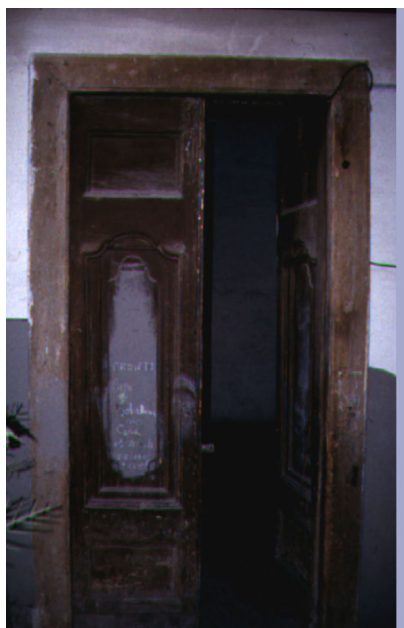
U.E. 42.1, Palazzo Caianiello, via S. Maria della Neve n. 34, porta di caposcala Nella profilatura principale, settecentesca, è inserito un pannello mistilineo, forse di analoga datazione, ma senza dubbio proveniente da altro pezzo d'opera, come dimostra l'incoerenza della sua sagomatura con quella del telaio.
