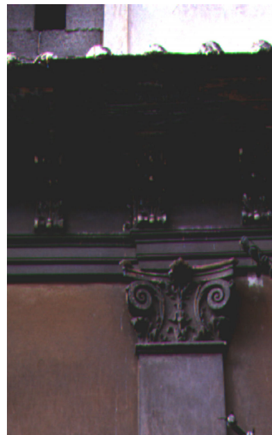
U.E. 26.11, Palazzo Argo, via C. Golia n. 38, cornicione della facciata, su modiglioni di stucco.
